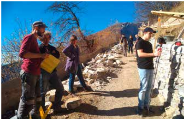
Trockenmauer am «Miliweg»: Der Wiederaufbau 2017 wurde dank der finanziellen Unterstützung des Naturparks Pfyn-Finges möglich.
